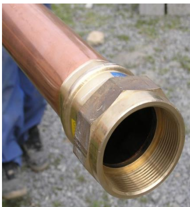
Obrázek 4: Detailní snímek šroubení měděné trubky tvořící primární okruh TČ [12]
