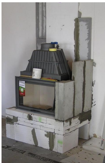
Obrázek 14: Počáteční fáze obestavby krbové vložky [12]
