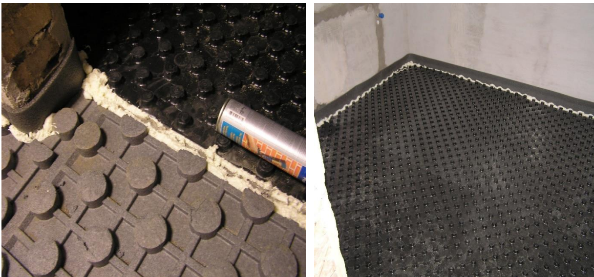
Obrázek 6 a 7: Detail spojení dvou systémových desek/Speciální systémová deska do koupelny[12]
