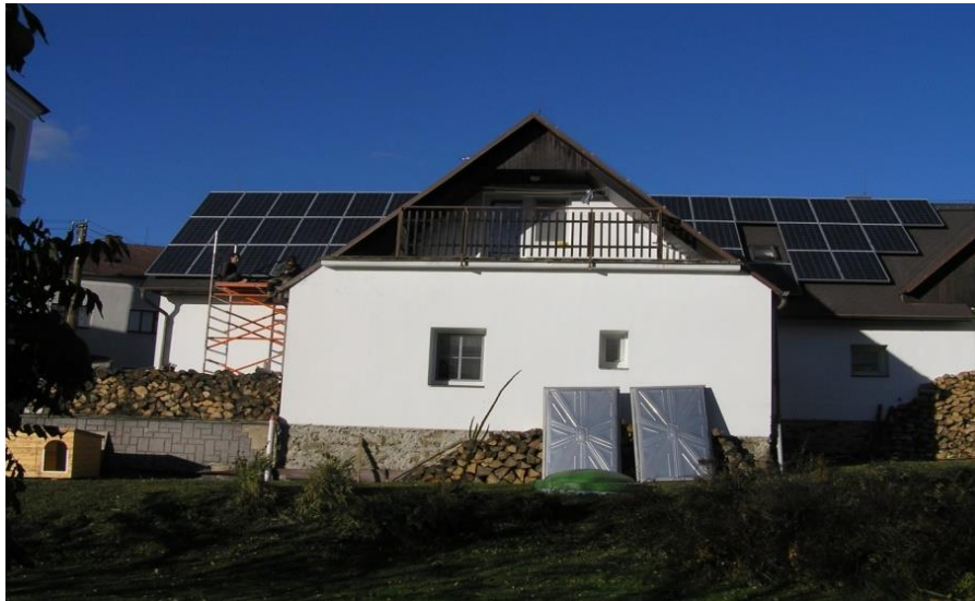
Obrázek 11: Instalace fotovoltaických panelů na střechu domu [12]
