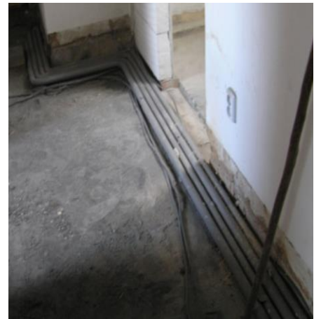
Obrázek 9: Sálání tepla podlahou vs. radiátory[3] Obrázek 10: Instalace potrubí k radiátorům[12]
