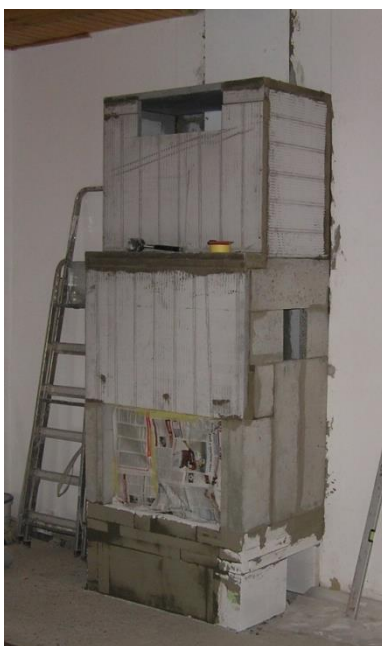
Obrázek 14: Počáteční fáze obestavby krbové vložky [12]
