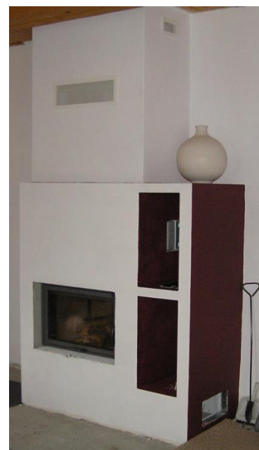
Obrázek 15: Druhá fáze obestavby krbové vložky po dokončení krytu komínové roury [12]
