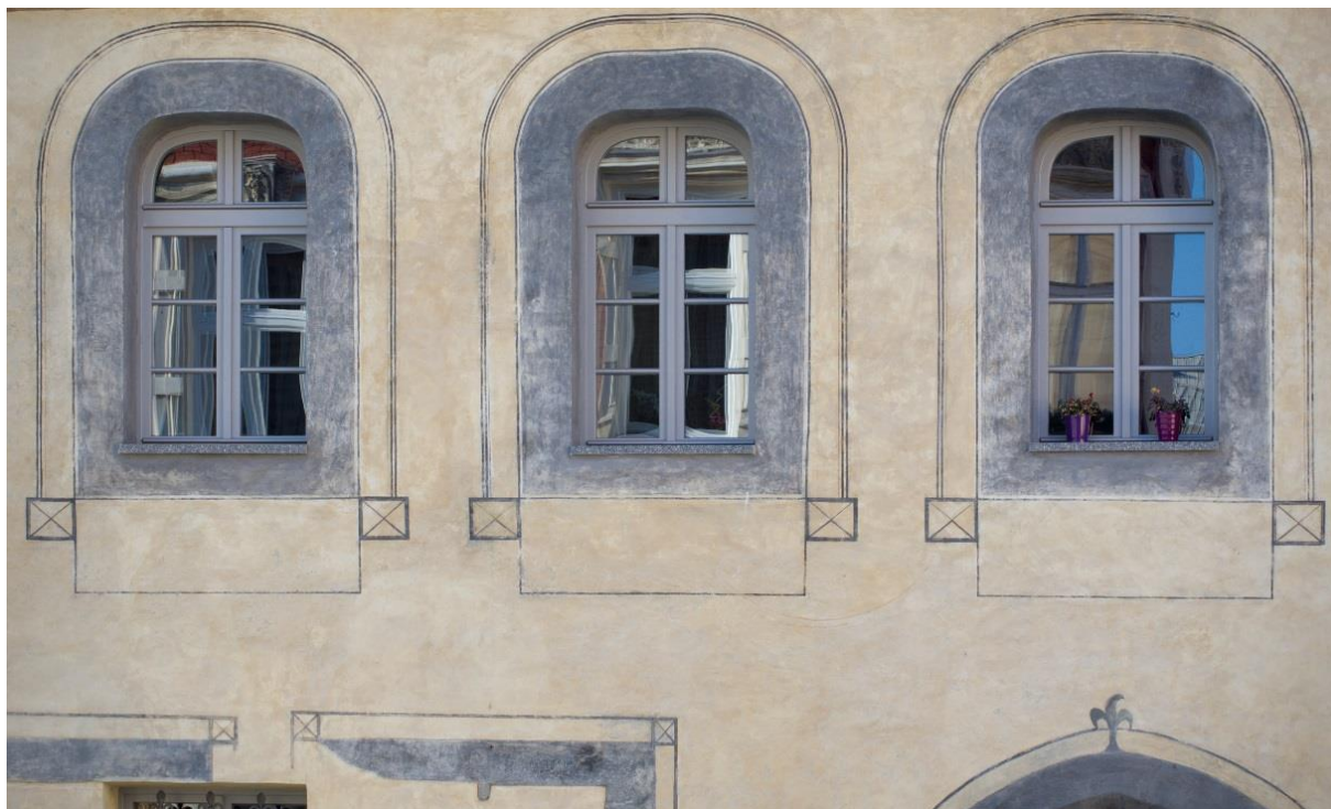
Obr. 41 Detail průčelí domu čp. 163, obnovená gotická podoba fasády z uliční strany
