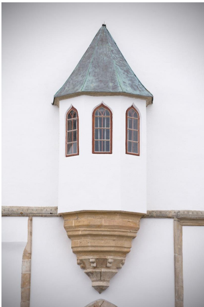
Obr. 17 Detailní fotografie radničního arkýře nalézajícího se na čelní straně radniční věže, nad zaklenutým podloubím
