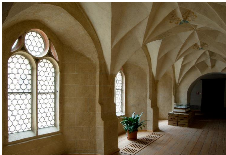
Obr. 4 Chodba s kružbovými okny, zaklenutá síťovou klenbou
