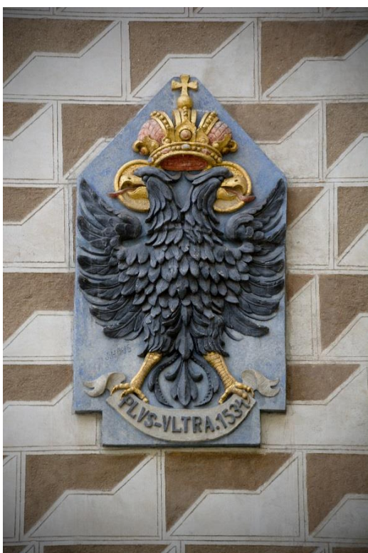
Obr. 32 Detailní fotografie erbu na uliční stěně domu čp. 18, na fotografii je patrná sgrafitová omítka
