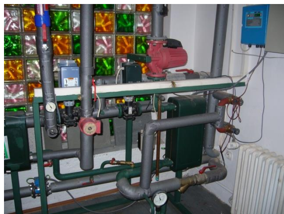
Obr. 19: Výměník CZT
