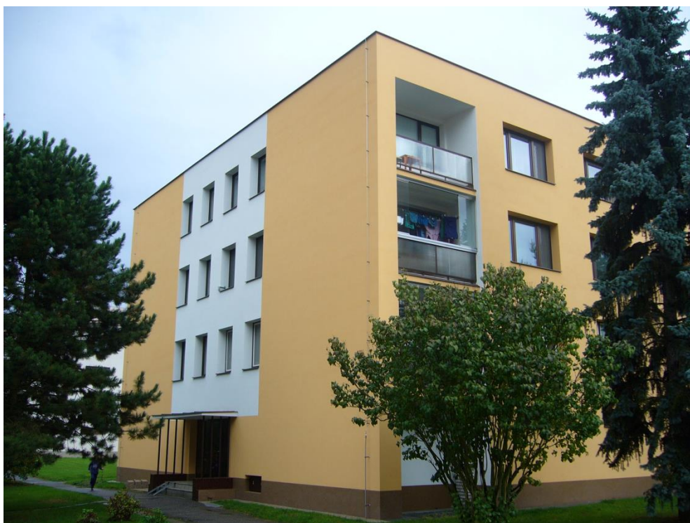
Obr. 5: Pohled na bytový dům, Družstevní 271
