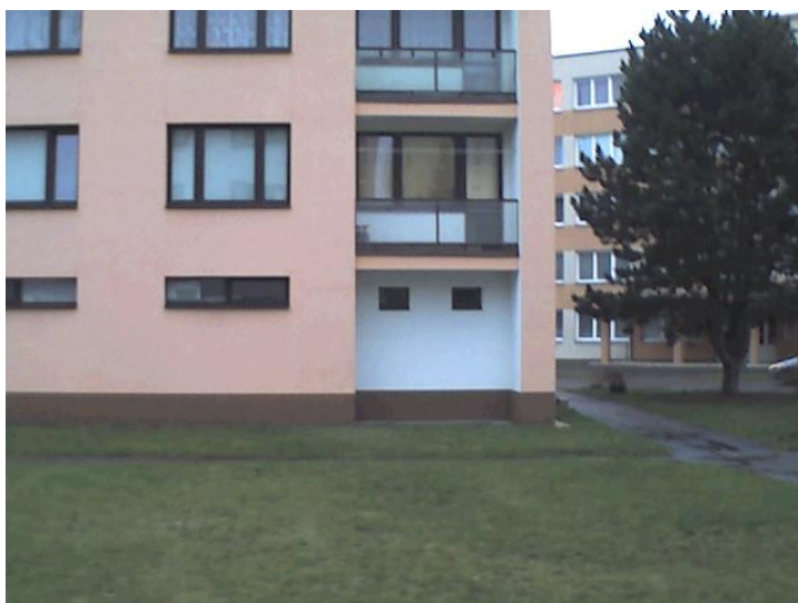
Obr. 1: Pohled na východní fasádu
