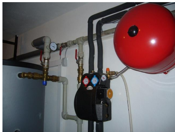
Obr. 14 a 15: Čerpadlo, trojcestný ventil a expanzní nádrž (solárního okruhu)
