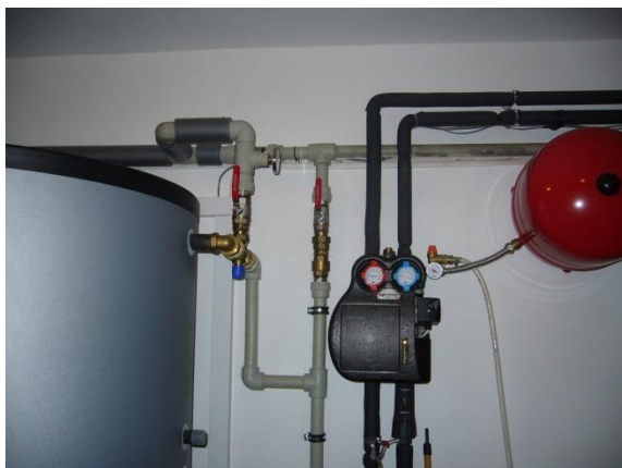
Obr. 14 a 15: Čerpadlo, trojcestný ventil a expanzní nádrž (solárního okruhu)
