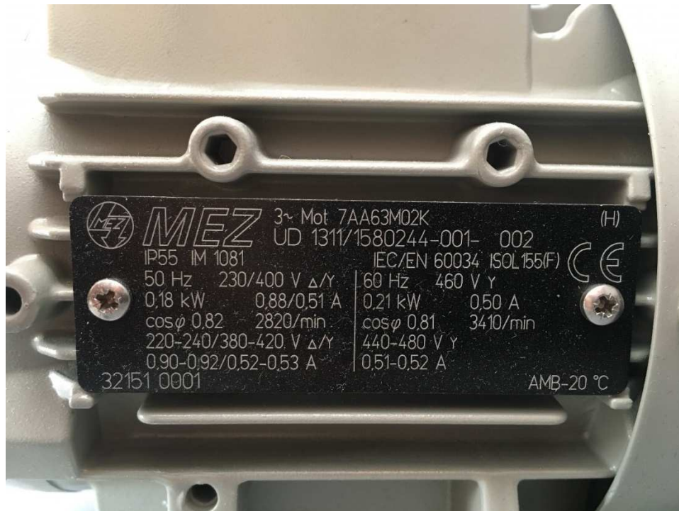
Obr. 3.2.1 Štítek motoru
