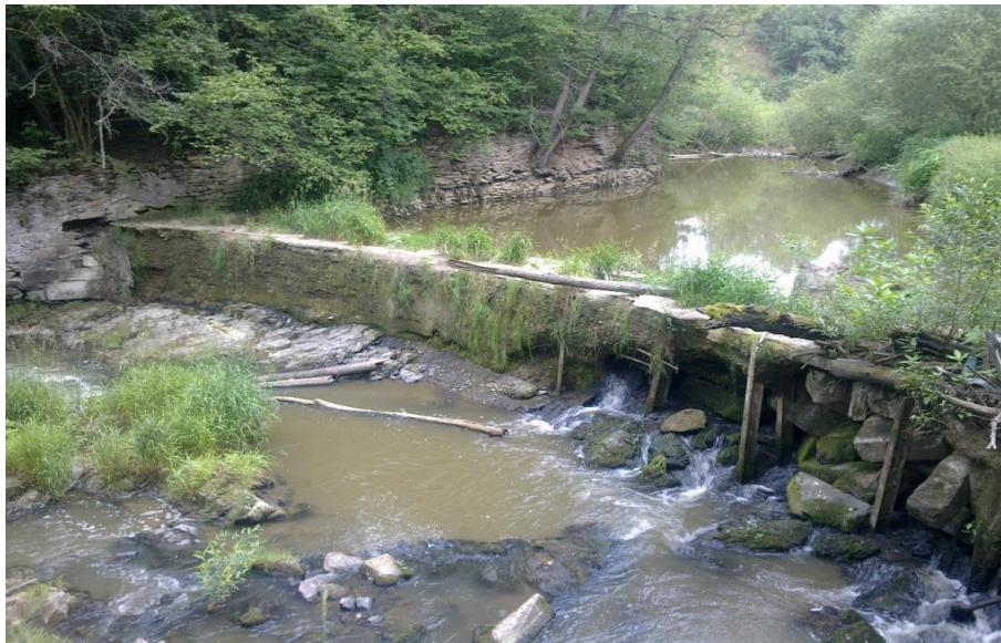
Obr. 4: Jez před rekonstrukcí [1]
