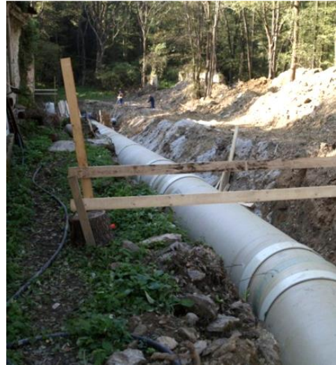
Obr. 12: Potrubní přivaděč před zakrytím [1]
