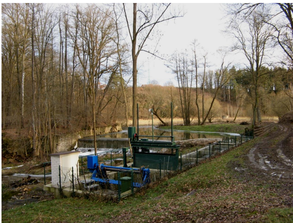
Obr. 8: Pohled na česlovnu v pozadí s jezem [1]
