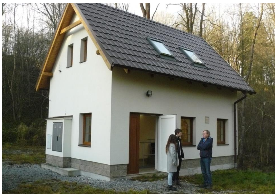
Obr. 17: Vrchní část strojovny [2]
