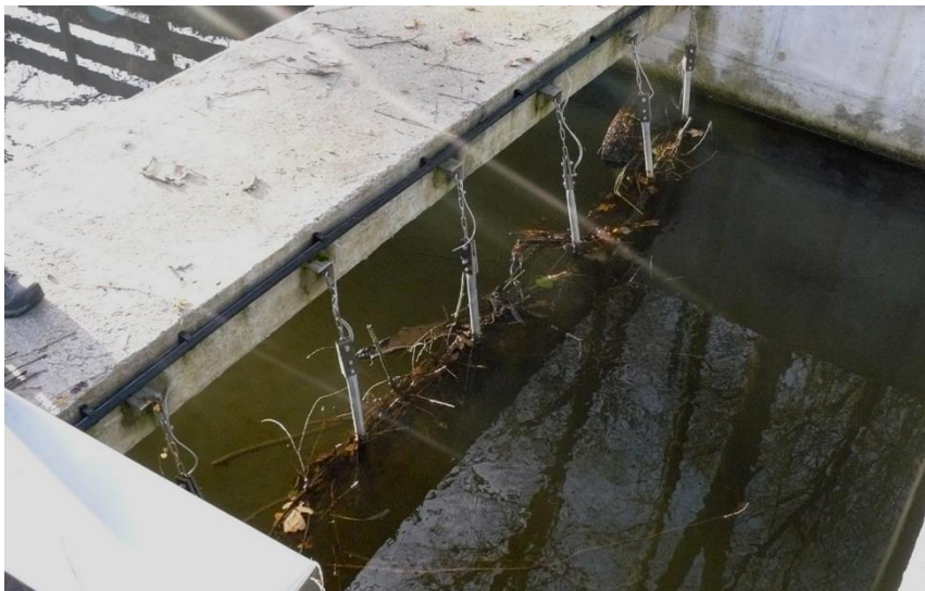
Obr. 6: Elektronický plašič na vtoku do náhonu [2]
