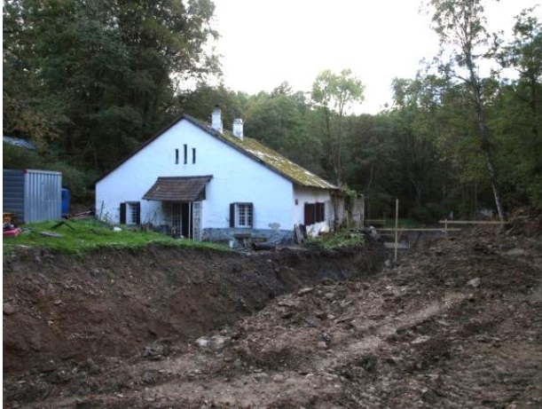
Obr. 11: Výkop pro potrubní přivaděč [1]
