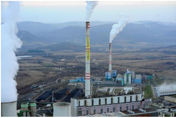
Obrázek 14 – Kondenzační parní elektrárna v Pruněřově
