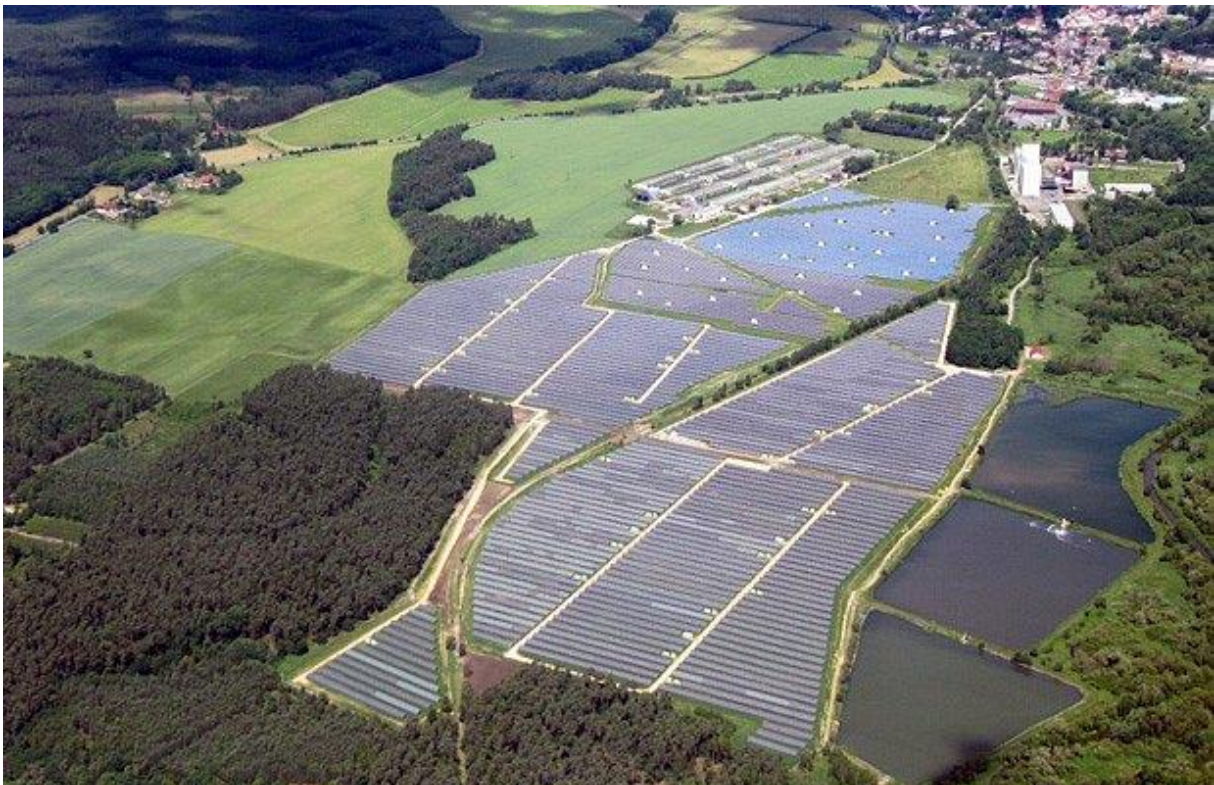
Solární elektrárna Ralsko
