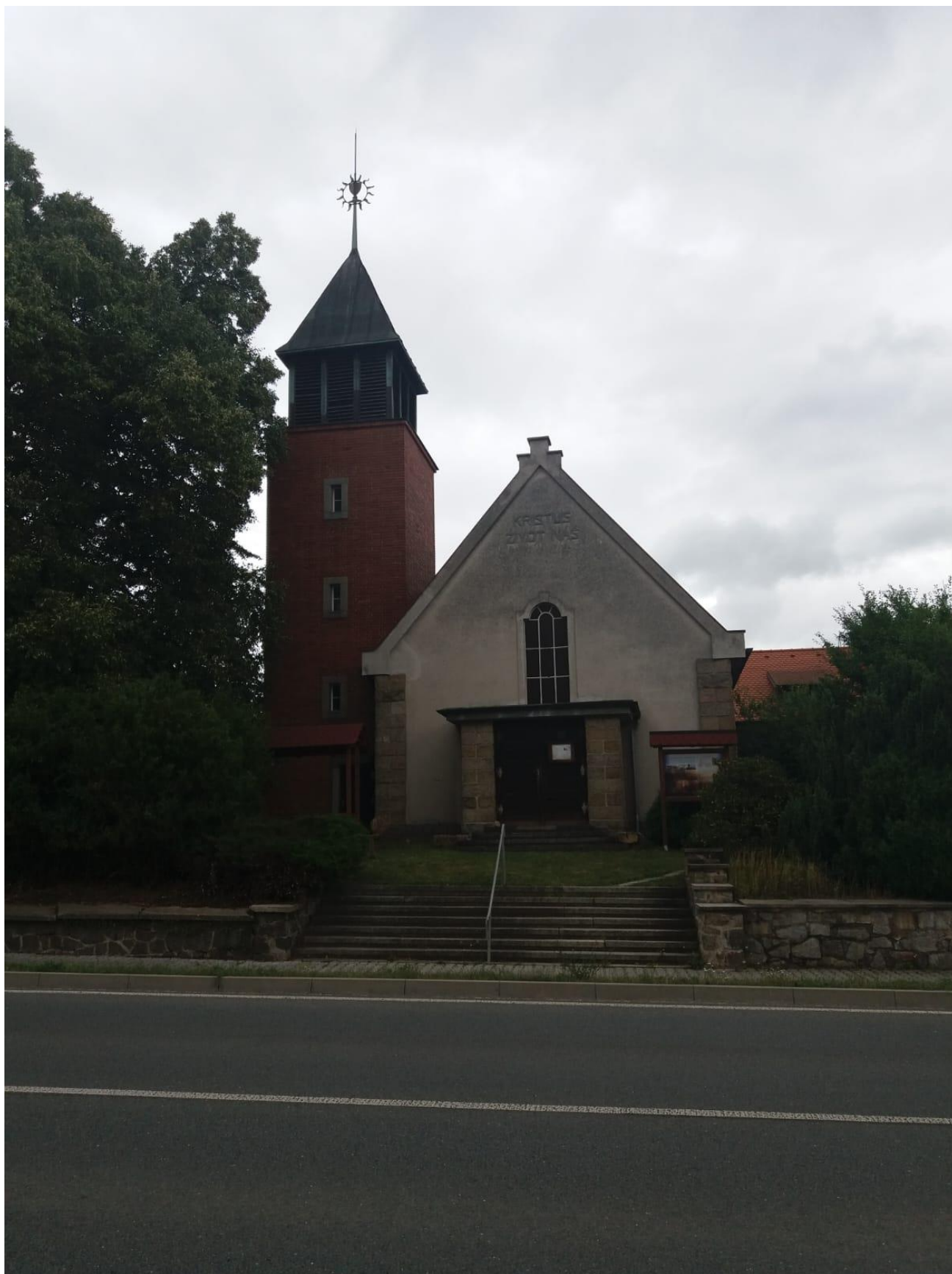
Příloha 7 Evangelický kostel v Kralovicích
