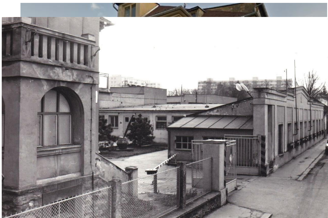
Obrázek 3- pohled na bývalou továrnu Jiřího Kohna, Štěpána Dvořáka 617
