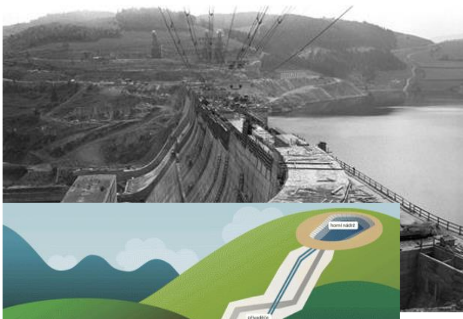
Obrázek 4: Výstavba přehrady Orlik [Dostupné z: https://www.lidovky.cz/byznys/foto/NEV3d3468_FO03010532.jpg ]
