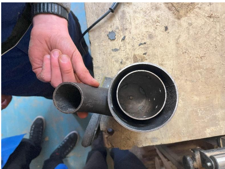
Obrázek 17 – Kontrola náklonu kolena ke spalovací komoře
