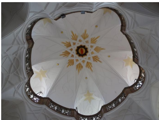
Obrázek 21: Poutní kostel sv. Jana Nepomuckého na Zelené Hoře - pohled na strop [6]
