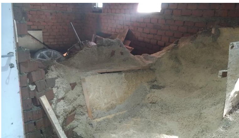
Obrázek 6 Pelety působením vody zvětšují svůj objem a rozpadají se [10]
