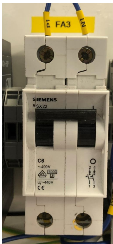
Obrázek 5 - Jištění 24V; Zdroj: Autor
