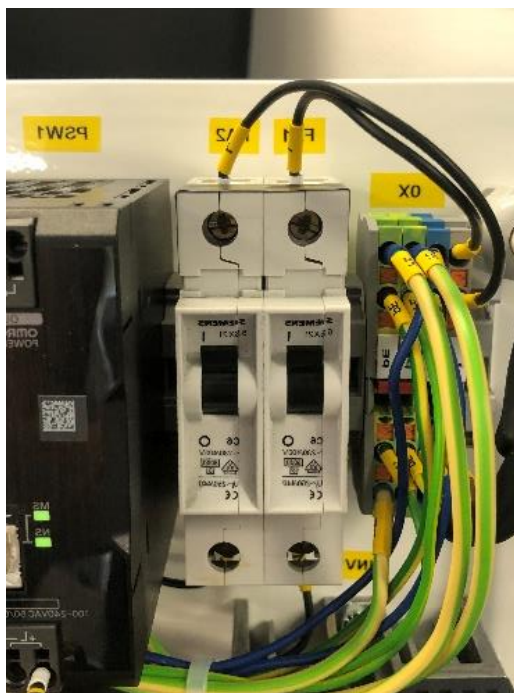
Obrázek 4 - Jištění nízkého napětí 2x230V; Zdroj: Autor
